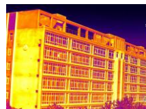
Inspección de edificios
